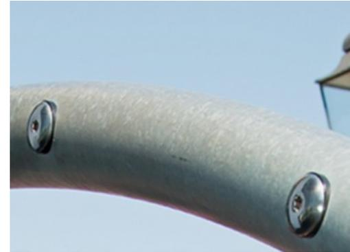
Die Stahlstruktur ist vollständig feuerverzinkt und bleifrei. Die Verzinkung sorgt für eine ausgezeichnete Korrosionsbeständigkeit in allen Aussenumgebungen und macht diese wartungsarm.
