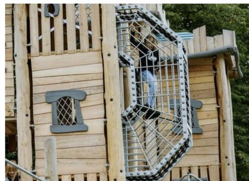
Le tunnel à ossature métallique est en acier galvanisé à chaud de haute qualité. Les cordes Corocord 16 mm sont de type 'Hercules' avec des fils en acier galvanisé à quatre torons et un noyau en fil d'acier. Chaque brin est étroitement enveloppé de fil PES, qui est fondu sur chaque brin individuel.
