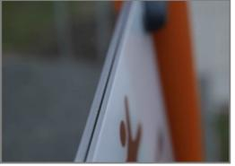
Die grossen Hinweisschilder sind in Sandwichbauweise aus 2 x 6 mm Polycarbonatplatten hergestellt, auf deren Innenseite klare Anweisungen aufgedruckt sind. Dies ergibt eine vandalismussichere Gestaltung.
