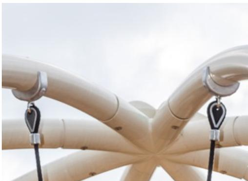
Las abrazaderas de aluminio Corocord se utilizan como conectores entre los postes de acero y la cuerda. La fundición de aluminio se atornilla en el poste de acero y se conecta de forma segura a la cuerda.
