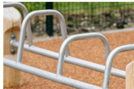
Die Stangen, die als Griffe für Übungen gedacht sind, bestehen aus feuerverzinktem Stahl mit einem Durchmesser von 38 mm. Ein geeigneter Durchmesser um die Handgelenke bei Dips oder Handständen zu unterstützen.
