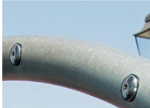
La structure est en acier galvanisé à chaud sur les faces intérieures et extérieures avec du zinc sans plomb. La galvanisation présente une excellente résistance à la corrosion en milieu extérieur et ne nécessite aucun entretien.
