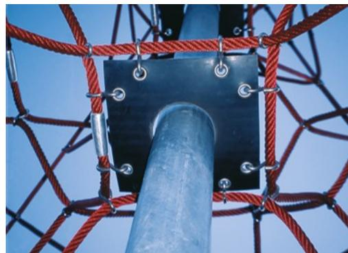
Les membranes Corocord sont constituées d'un matériau caoutchouc résistant au frottement, de qualité équivalente aux tapis roulants et possédant une excellente résistance aux UV. Testé et conforme aux exigences du règlement REACH en matière de HAP. Une armature à quatre couches en polyester tissé est intégrée. L'épaisseur totale de la membrane est de 7,5 mm.
