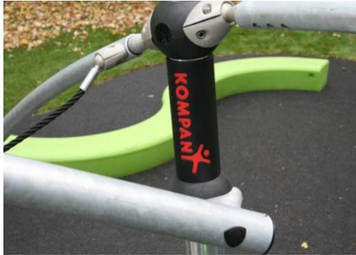
Las superficies de acero de GALAXY están galvanizadas en caliente por dentro y por fuera con zinc sin plomo. La galvanización tiene una excelente resistencia a la corrosión en ambientes exteriores y requiere poco mantenimiento.
