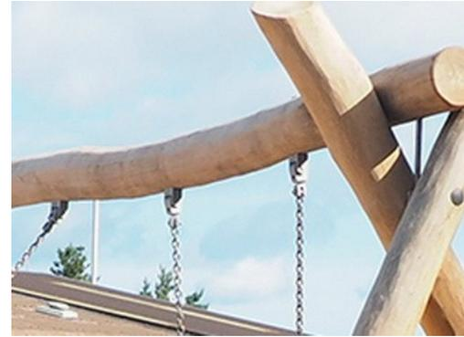
Die Schaukelaufhängungen bestehen aus hochwertigem PA6 mit integrierten dauergeschmierten Kugellagern. Die höhenverstellbaren Ketten werden durch Edelstahl-Haken angebracht, die diebstahlgesichert und mit einem Anti-Überschlag-Gehäuse versehen sind.
