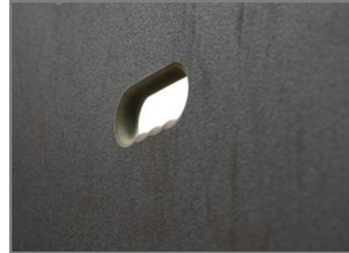
Die Wandoberfläche besteht aus 17,8 mm dicken HPL-Platten (High Pressure Laminate), um optimale Festigkeit und Haltbarkeit zu gewährleisten.
