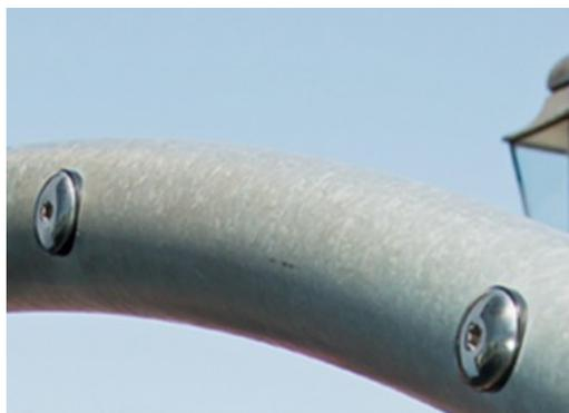
La struttura in acciaio è zincata a caldo all'interno e all'esterno con zinco senza piombo. La zincatura ha un'eccellente resistenza alla corrosione in ambienti esterni e richiede una bassa manutenzione.
