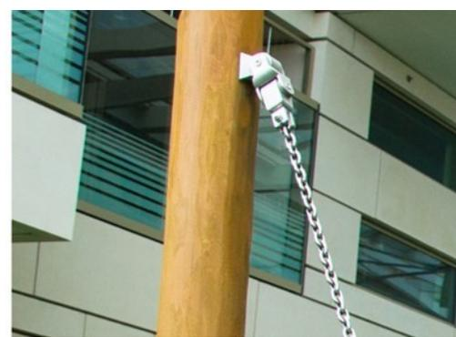
Les suspensions de la balançoire sont fabriquées en polyamide et se composent d'un système de roulement à double bille avec pivot.
