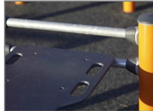
所有甲板均由高压层压板 HPL 制成，厚度为 17.8mm，并且根据 EN 438-6 具有防滑表面纹理。KOMPAN HPL 具有很高的耐磨强度，可确保在所有气候下均具有较长的使用寿命。
