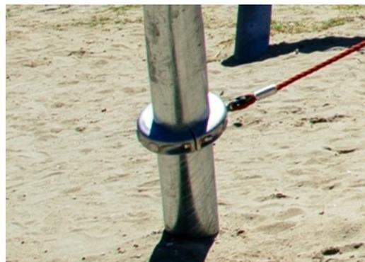
Las abrazaderas de aluminio Corocord se utilizan como conectores entre los postes de acero y la cuerda. Dos piezas de fundición de aluminio están atornilladas juntas. La altura de las abrazaderas es, por lo tanto, variable.
