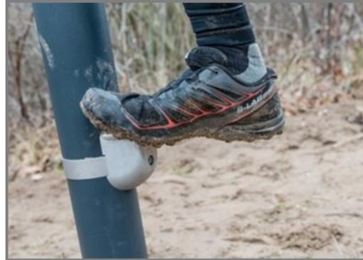
Die Stufen bestehen aus extrudiertem Aluminium mit einer rutschfesten Oberfläche. Aluminium hat eine hohe Korrosionsbeständigkeit und gewährleistet die Haltbarkeit des Produkts. Die Stufen wurden in Höhen von 34,7 cm und 54,7 cm montiert, was einen leichten Zugang zum Erreichen der Überkopfaktivität ermöglicht.
