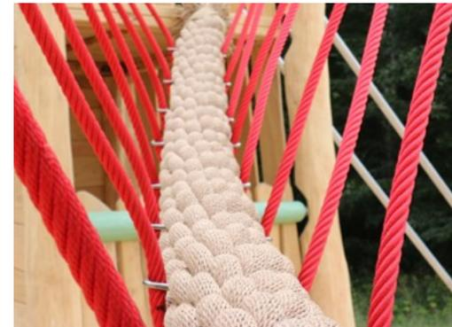
桥梁的 Corocord 绳索使用特殊的“大力神”型，带有镀锌六股钢丝和钢丝芯。椰子风格的 PP 绳直径为 15 厘米。内部钢丝芯的两端都有顶针，这些顶针用作将绳索固定到现有连接元件上的附件。
