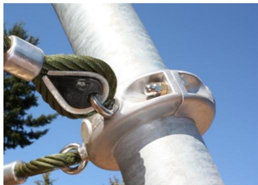
Les étriers en aluminium Corocord sont utilisés comme connecteurs entre les poteaux en acier et les câbles. Deux pièces en aluminium moulées sont fixées l'une à l'autre. La hauteur des attaches est donc variable.
