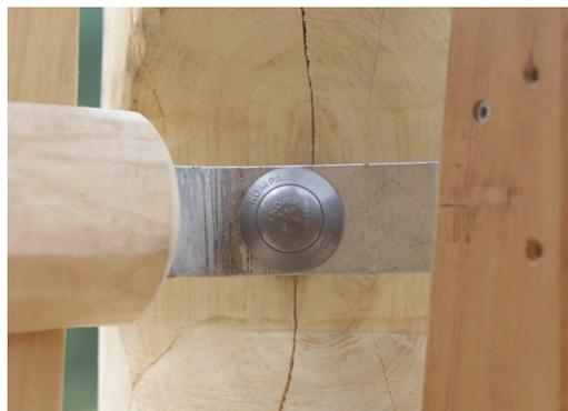
硬件由不锈钢或镀锌钢制成，以确保具有高耐腐蚀性的耐用连接。
