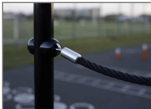
Les cordes sont fabriquées en PA stabilisé aux UV renforcé d'un câble en acier. La corde est traitée par induction afin de créer une soudure solide avec l'acier et ainsi garantir une excellente résistance à l'usure.
