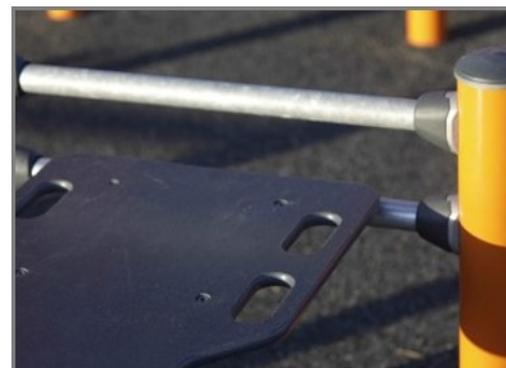
La superficie è costituita da pannelli Ekogrip, costituiti da polietilene da 15 mm con uno strato superiore di gomma termoplastica da 3 mm. I pannelli Ekogrip hanno un effetto antiscivolo per un allenamento comodo e sicuro in tutte le circostanze atmosferiche.
