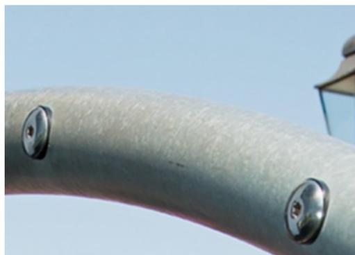
Gli archi in acciaio sono zincati a caldo all'interno e all'esterno con zinco senza piombo. La zincatura ha un'eccellente resistenza alla corrosione in ambienti esterni e richiede una bassa manutenzione.
