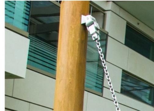
Die Schaukelaufhängungen bestehen aus Polyamid und sind mit einem zweifachen Kugellager ausgestattet.
