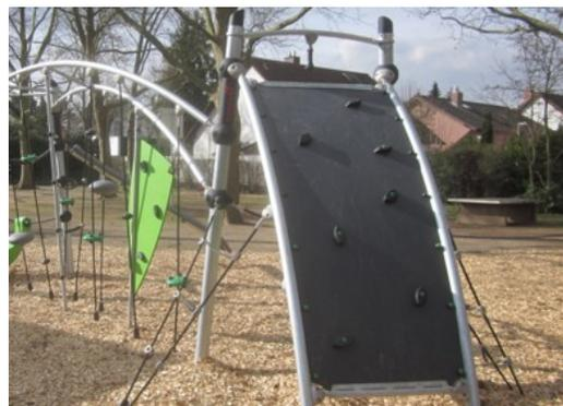
La parete da arrampicata curva è realizzata con una struttura in acciaio supportata da un pannello Ekogrip® con bitte di arrampicata dal design unico. Il pannello Ekogrip® è costituito da una base in PE di 15 mm di spessore con uno strato superiore di gomma di 3 mm con effetto antiscivolo.
