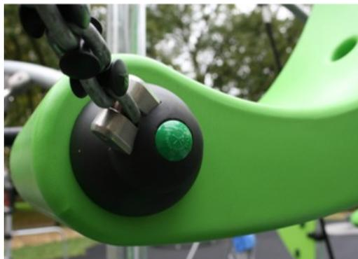
Le attività più importanti sono realizzate in PE riciclabile al 100%. La conghiglia visualizzata è modellata in un unico pezzo con uno spessore minimo di 5 mm. Il PE ha un'elevata resistenza agli urti su un ampio intervallo di temperatura che garantisce resistenza agli atti vandalici in tutti i luoghi.
