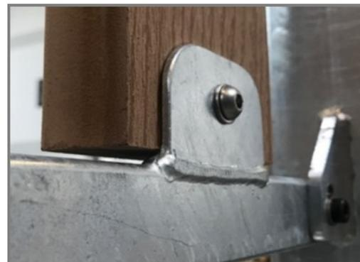
Die Holz-Kunststoff-Verbund-Bretter (WPC) sind durch Edelstahlschrauben (M8 Gewinde), Muttern und Unterlegscheiben mit 70 x 45 x 3 mm großen, geschweißten Flanschen verbunden. Diese Verbindungen sind von innen nicht sichtbar und bilden eine stabile und sichere Verknüpfung.
