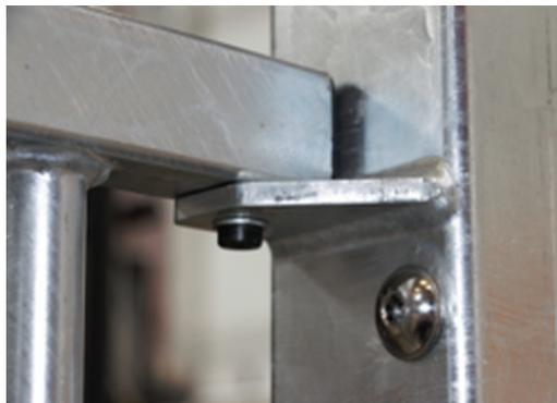
Alle Stahl Komponenten werden aus Karbonstahl gefertigt, geschweißt nach EN ISO 5817 und feuerverzinkt nach ISO 1461. Dieser Prozess gewährleistet eine lange Lebensdauer in allen Umgebungen.
