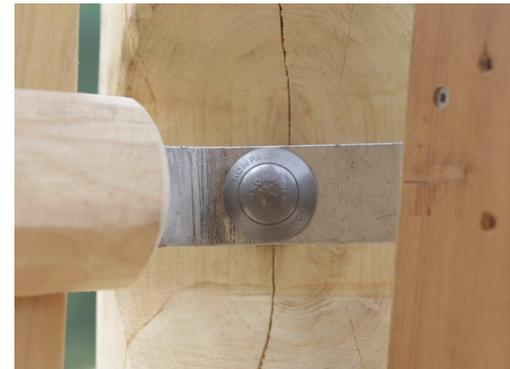
Die Verbindungselemente werden aus Edelstahl oder verzinktem Stahl gefertigt, um für eine hohe Korrosionsbeständigkeit zu sorgen.
