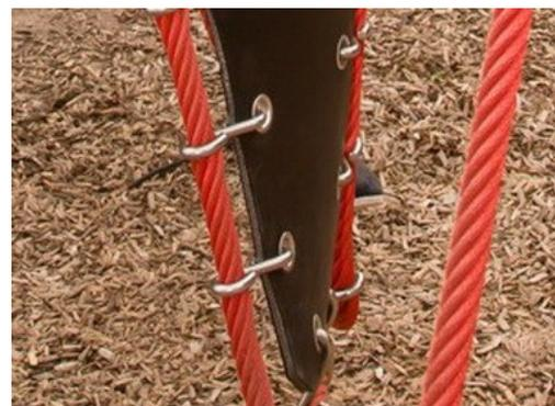
Les membranes Corocord sont constituées d'un matériau en caoutchouc aux propriétés de résistance au frottement équivalentes à celles des courroies et possèdent une excellente résistance aux UV. Testé et conforme aux exigences du règlement REACH en matière de HAP. Un blindage à quatre couches en polyester tissé est intégré. Le blindage et les deux couches de surface forment une épaisseur totale de 8 mm.
