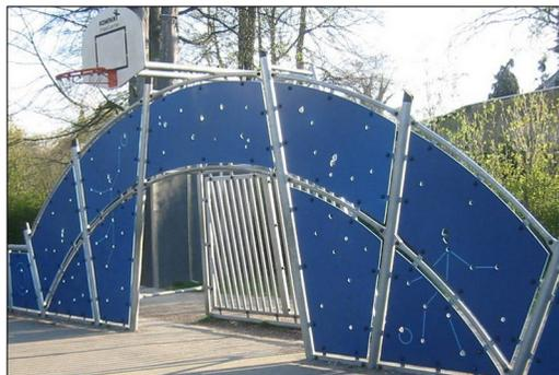
Le but mesure ~140cm de profondeur et ~330cm de largeur avec tous les poteaux en acier galvanisé avec un traitement de surface galvanisé à chaud. Le cadre avant est fabriqué avec des tubes de Ø48, et l'arrière du but utilise 10 tubes d'un diamètre de ø38.
