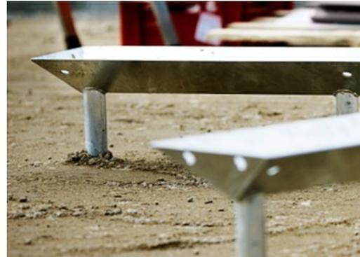
Die Würfel verfügen über ein einzigartiges Fundament, welches die passgenaue Positionierung der Würfel sicherstellt.
