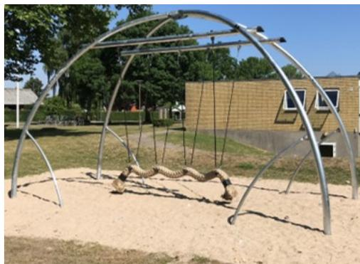
钢管内部和外部均用无铅锌热浸镀锌。镀锌在外部环境中具有出色的耐腐蚀性，并且维护成本低。
