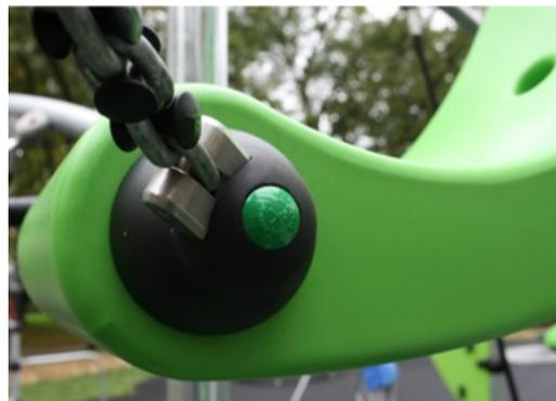
Les principales activités ludiques sont fabriquées en polyéthylène (PE) 100 % recyclable. Les coques sont moulées en une seule pièce avec une épaisseur minimale de 5 mm. Le PE présente une résistance élevée aux chocs sur une grande plage de température, assurant une résistance au vandalisme dans tous les pays.
