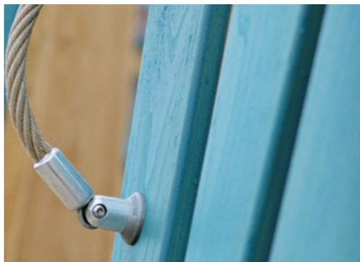
La peinture utilisée pour les composants colorés est à base d'eau, respectueuse de l'environnement et offre une excellente résistance aux UV. La peinture respecte la norme EN 71 Partie 3.
