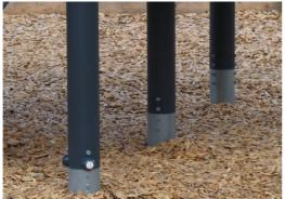
Los postes principales con zapata de acero galvanizado en caliente están disponibles en diferentes materiales: postes de madera de pino impregnados a presión. Pregalvanizado interior y exterior con postes de acero con acabado superior con recubrimiento en polvo. Aluminio sin plomo con acabado superior anodizado en color.
