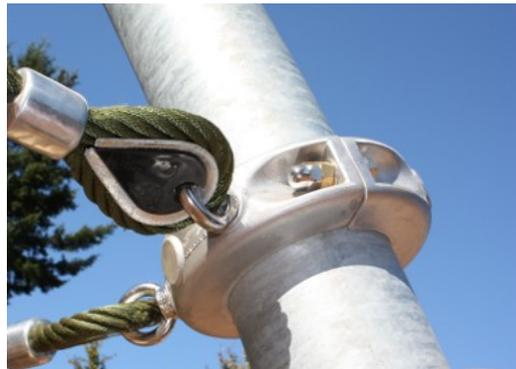
Corocord 铝夹是钢柱和绳索之间的连接配件。两个铝铸件用螺栓固定在一起。因此，夹具的高度是可调整的。
