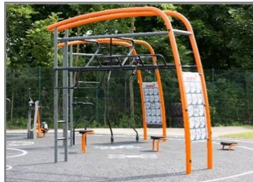
Um die Unversehrtheit des Hauptrahmens zu gewährleisten, werden die orangefarbenen Hauptpfosten aus Stahlpfosten  $\varnothing 101,6 \times 3$  mm hergestellt, die feuerverzinkt und pulverbeschichtet in Orange (RAL2010) sind. Die Stützpfeiler erhalten die gleiche Oberflächenbehandlung und bestehen aus Stahlrohren  $\varnothing 76,1 \times 3,6$  mm, die grau (RAL7012) pulverbeschichtet sind.
