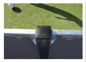
Die Pfosten sind aus 80 x 80 x 3 mm Querschnitten mit horizontal geschweißten 6 mm Flanschen gefertigt. Dies ermöglicht eine einfache Montage und eine stabile Konstruktion. Die Polyethylen Kappen auf den Pfosten sind mit Blindnieten befestigt.
