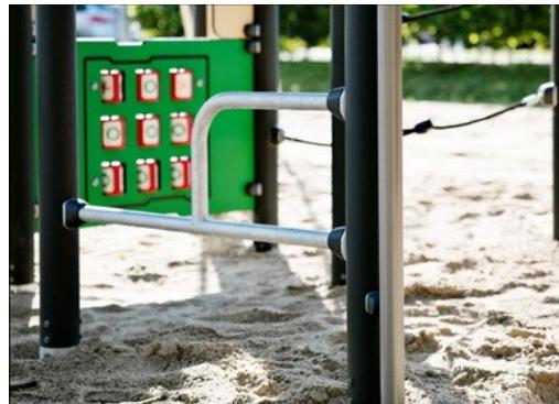
主立柱采用合金材料，提高了抗拉强度和韧性，确保高塔结构的完整性。具有热浸镀锌底座和粉末涂层表面处理，使用寿命长。
