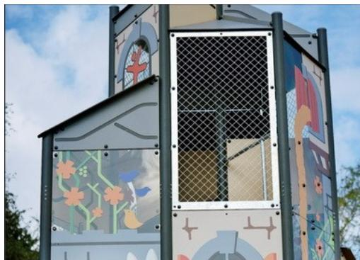
完全焊接的钢框架，带有直径为 4mm 的圆形钢销的 45° 交叉焊接钢网格。气流面板有助于 GIANT 塔的整体结构完整性。
