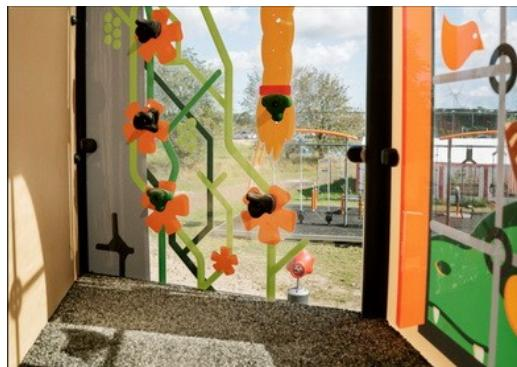
优质聚碳酸酯，厚度 15mm。图形采用独特的多层打印工艺，内层为图像，外层为透明层保护。聚碳酸酯面板和水性漆都是防紫外线的，不易褪色。
