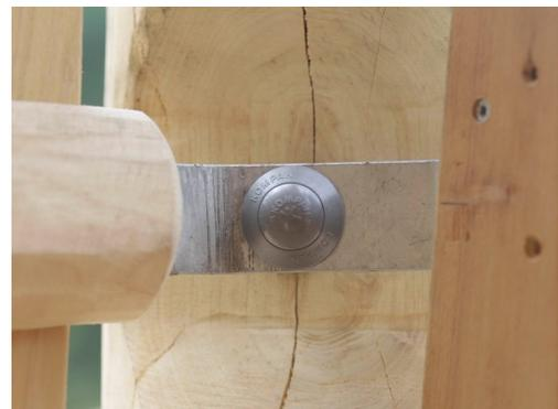
L'hardware è realizzato in acciaio inossidabile o acciaio zincato per garantire connessioni durature con un'elevata resistenza alla corrosione.
