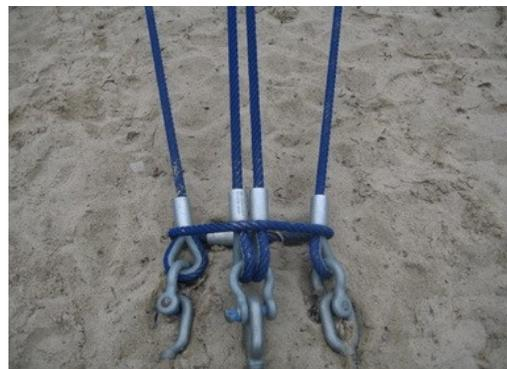
Enormes estructuras de red tridimensional están aseguradas a los cimientos con un sistema de tres tensores individuales, que luego se conectan a anclajes de acero individuales. Este sistema garantiza que cada cable de borde se pueda tensar por separado y aumenta la seguridad estructural mediante un anclaje independiente.
