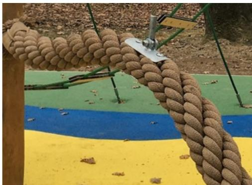
Das PP-Seil in Kokostau-Optik hat einen Durchmesser von 15 cm. Der innere Stahldrahtkern ist an beiden Enden mit Kauschen versehen, welche zum Befestigen des Taus an die Verbindungselemente dienen.
