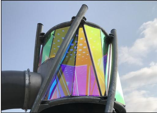
Die grafischen Tafeln sind aus hochwertigem Polycarbonat (PC) mit einer Dicke von 6 mm hergestellt. Die farbwechselnde dichroitische Folie ist außen aufgeklebt. Die PC-Platten sind UV-stabilisiert, um einen Zerfall des Materials zu verhindern.
