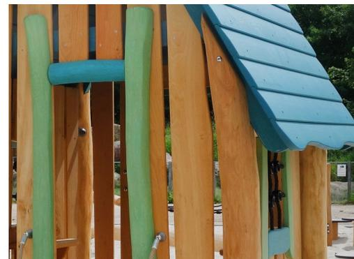
La pintura utilizada para los componentes coloreados es ecológica a base de agua con excelente resistencia a los rayos UV. La pintura cumple con EN 71 Parte 3.
