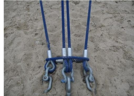
Die riesigen Raumnetzstrukturen werden im Fundament durch ein System von drei Spannschlössern gesichert. Horizontale und vertikale Kabel werden an die einzelnen Spannschlösser angebracht, welche mit den einzelnen Stahlankern verbunden sind. Dieses System sorgt dafür, dass jedes Kabel separat gespannt werden kann und erhöht die Tragsicherheit durch das unabhängige Verankern.
