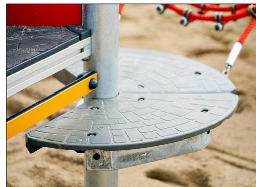
Las cubiertas de postes redondos grises están soportadas por acero galvanizado por inmersión en caliente y fabricadas con material moldeado de PP postconsumo al 75% con un patrón antideslizante y una superficie texturizada.
