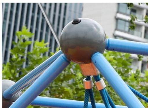
Les pièces en acier sont galvanisées à chaud sur les faces intérieures et extérieures avec du zinc sans plomb. Un thermolaquage est ajouté sur la surface extérieure. Cela assure une excellente résistance à la corrosion ainsi qu'un design coloré.
