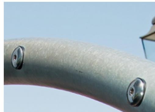
钢结构的内部和外部均使用无铅热浸镀锌。镀锌在外部环境中具有出色的耐腐蚀性，并且维护成本低。
