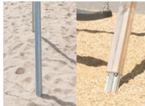
Il palo delle altalene A-Frame è disponibile per l'ancoraggio superficiale con bulloni di espansione o interrato con profondità di 60 cm o 90 cm. Le gambe in acciaio zincato a caldo sono ancorate direttamente nel terreno. I pali in legno di pino sono rialzati da terra da un unico basamento in acciaio zincato a caldo profilato.
