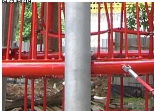
Las partes metálicas están hechas de acero de alta calidad, galvanizado en caliente por dentro y por fuera con zinc sin plomo. En el exterior, hay una capa adicional de recubrimiento en polvo. Esto garantiza una excelente resistencia a la corrosión y una expresión de diseño colorida.
