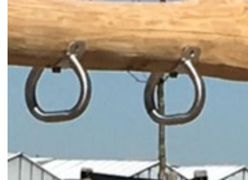
Die Klettergriffe sind aus Edelstahl gefertigt. Die Griffe werden mit Verbindungselementen aus Edelstahl an den oberen Robinia Querträger angebracht.
