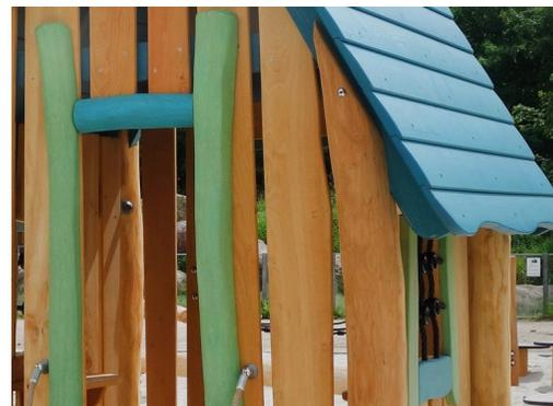
La peinture utilisée pour les composants colorés est aqueuse, respectueuse de l'environnement et a une excellente résistance aux UV. La peinture respecte la norme EN 71 Partie 3.
