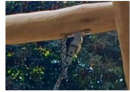
刺槐木横梁的秋千吊架由不锈钢支架制成,可以 在两个轴上移动。法兰轴承富含硅树脂,使悬架 免维护。
